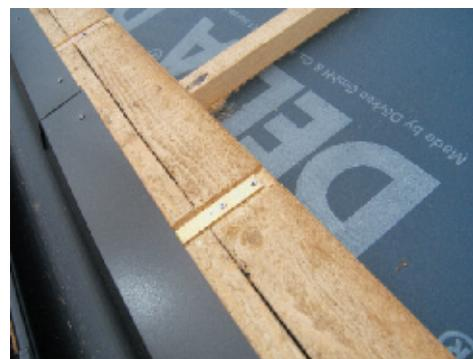
Рис. 8. Конструкция с высоким расположением желоба
