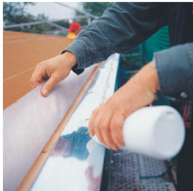
Рис. 2. Соединение мембраны и карнизной планки (фото DORKEN)
