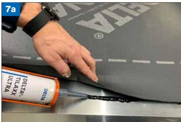
**(Рис. 7а)** Склеивание мембраны с карнизной планкой / капельником выполняется клеем DELTA®-TILAXX ULTRA. (расход ок. 45 мл/пог.м, ок. 7 м/картридж 290 мл). Клеевой жгут должен быть непрерывным, его не следует разглаживать!
