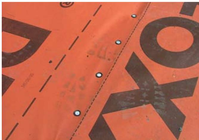
Рис. 16. Допустимое открытое крепление гвоздями с уплотнением
