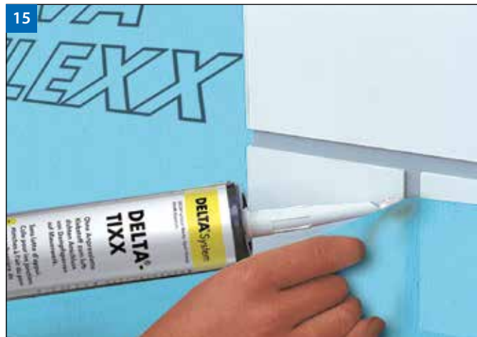
Примыкание к трубе/стене (Рис.15) Соединение с дымоходом (кирпичная кладка, керамические дымоходы) производится с помощью клея DELTA®-TIXX. Проклейте разрезы плёнки на внутренних и наружных углах с помощью ленты DELTA®-FLEXX-BAND. В качестве альтернативы можно использовать пасту DELTA®-LIQUIXX.
