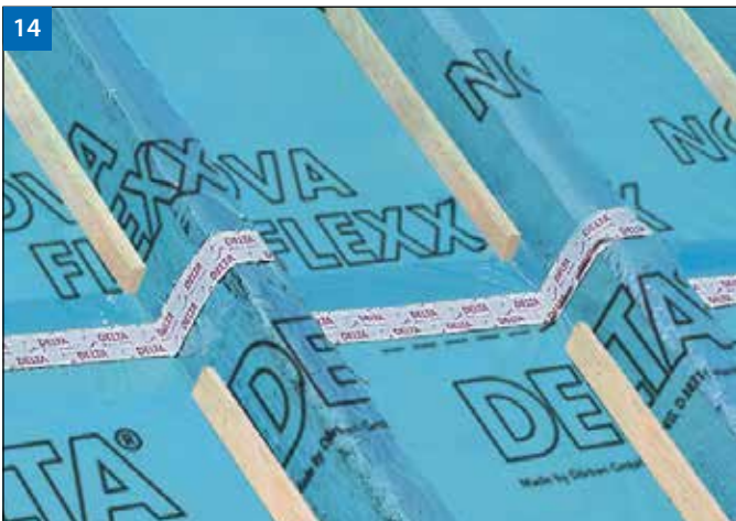
(Рис.14). Убедитесь, что зона нахлёстов рулонов остаётся свободной от прижимных реек, чтобы впоследствии её можно было склеить с помощью односторонней ленты DELTA®-MULTI-BAND.
