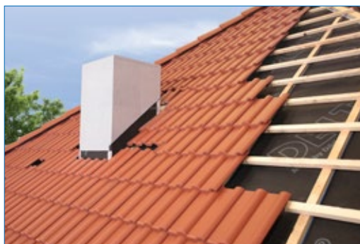
Рис. 6: В закрытом состоянии мембрана защищена от УФ-излучения, но продолжается воздействие тепла и движение воздуха в подкровельном пространстве.
