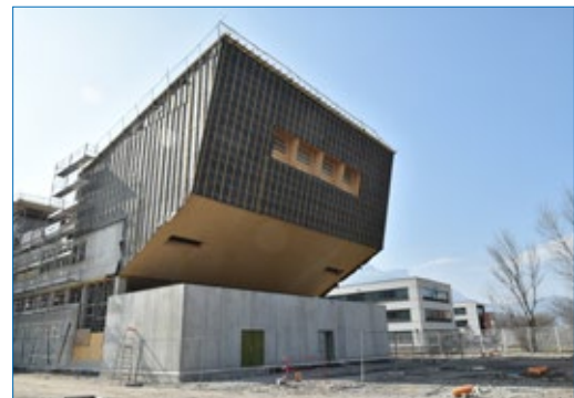
Fig. 5 : Pare-pluie pendant la phase chantier
