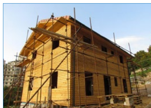
Fig. 5 : Pare-pluie pendant la phase chantier
