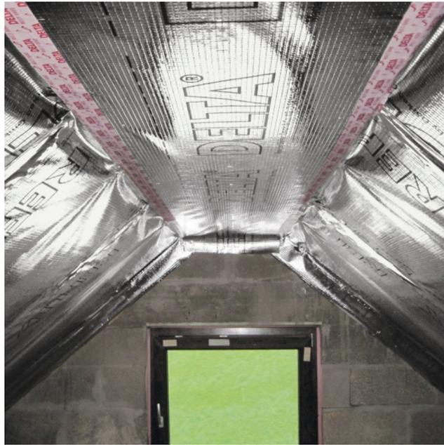
La posa combinata di materiali tecnologici come Schermi e Membrane Traspiranti sintetici (SMT) è uno strumento di facile applicazione per realizzare un involucro a tenuta ermetica e a risparmio energetico sia a livello delle coperture che delle facciate. L'obiettivo è quello di evitare la formazione di condensa all'interno dell'isolamento termico e garantire la tenuta ermetica dell'edificio.
