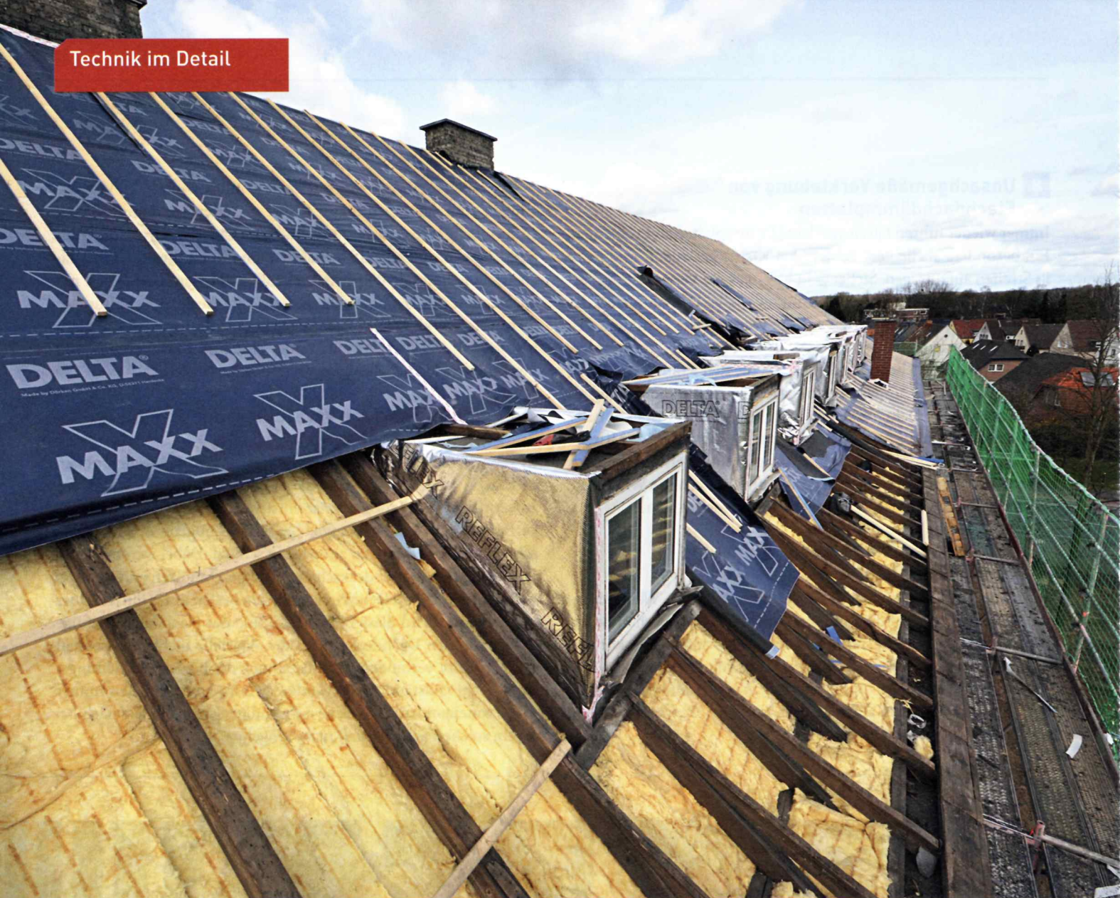
▲ Naht- und perforationsgesicherte Unterspannung der Klasse 3, ausgeführt mit einer Unterdeckbahn UDB-A, die auch als USB-A verwendet werden kann
