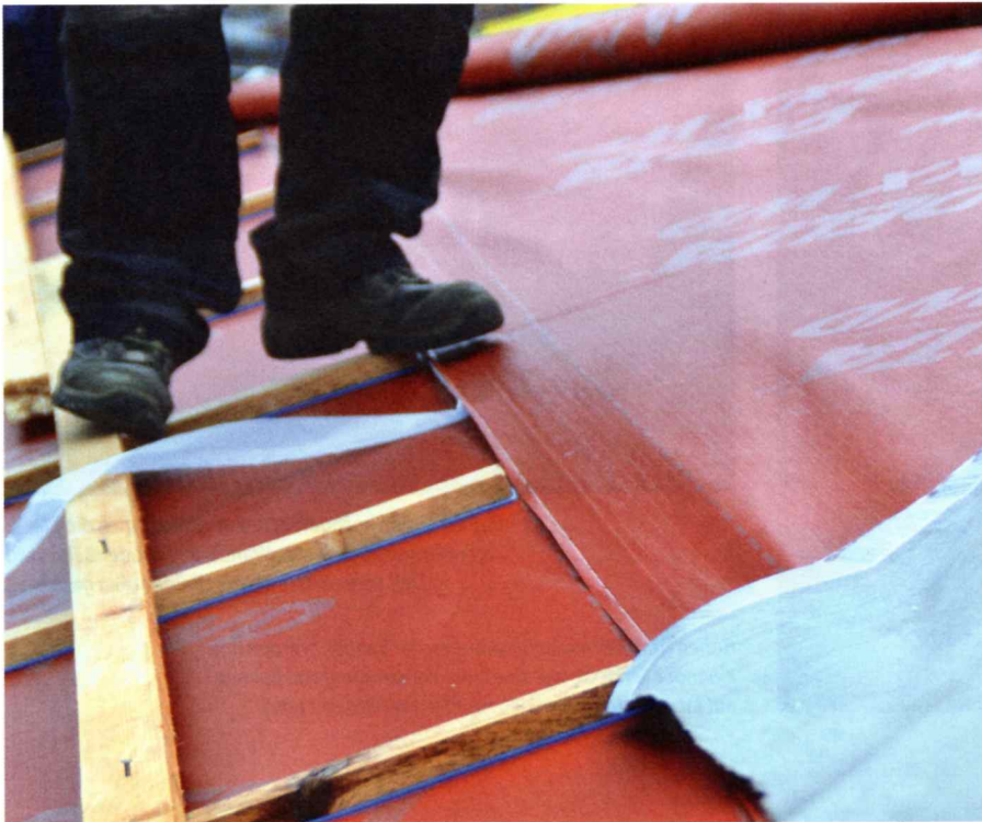
Die Befestigungsstellen der Konterlattung, ob genagelt oder geschraubt, müssen mit Nageldichtungsbändern abgedichtet werden.
