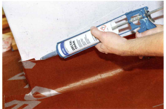
Der am Kamin hochgeführte und später durch die Blechverwahrung abgedeckte Wandanschluss der Bahn wird mit Klebmasse gegen Hinterlaufen gesichert.
