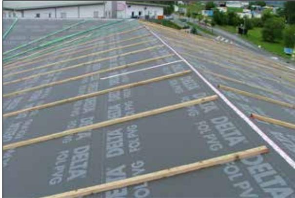
Zwischen Sturmplatte und Vordeckbahn ist dort wo genagelt wird, zur Vermeidung des Wassereintrags durch die Befestigungsstellen, eine Perforationssicherung mit einem Abschnitt DELTA®-Nageldichtungsband (DELTA®-DICHT-BAND D 50 / DELTA®-SCHAUM-BAND SB 60) vorzusehen.
