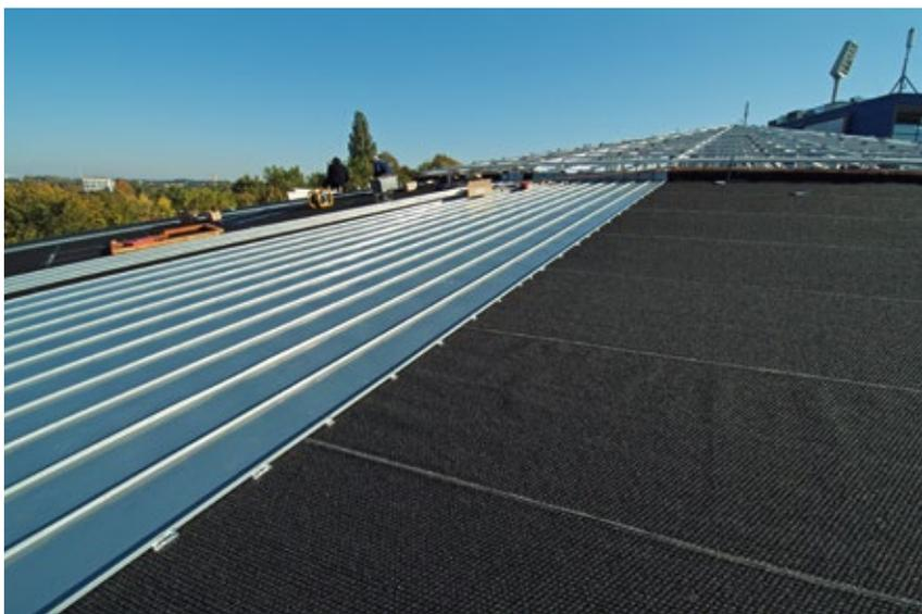
DELTA®-TRELA PLUS als Trennlage bei Metalldeckung.
