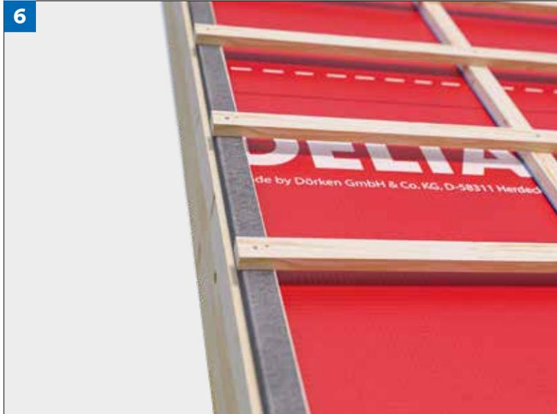
**(Bild 6)** Bei Dächern mit Ortüberstand sind die Bahnen soweit wie möglich nach außen auf eine ausreichend tragfähige Auflage z. B. außenliegender Sparren zu verlegen und auf die Konter- oder Traglattung hochzuführen und zu fixieren.
