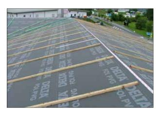
Zwischen Sturmlatte und Vordeckbahn ist dort wo genagelt wird, zur Vermeidung des Wassereintrags durch die Befestigungsstellen, eine Perforationssicherung mit einem Abschnitt DELTA®-Nageldichtungsband (DELTA®-DICHT-BAND D 50 / DELTA®-SCHAUM-BAND SB 60) vorzusehen.
