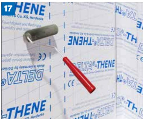
**(Bild 17)** Alle Überlappungen, An- und Abschlüsse sorgfältig nacharbeiten und mit einer Andruckrolle andrücken.
