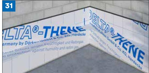
Bei der Verwendung als L-Sperre bzw. Sockelabdichtung wird DELTA®-THENE vollflächig auf den zuvor grundierten Flächen aufgeklebt. Der Untergrund muss eben sein und es dürfen keine Horizontalkräfte übertragen werden.
