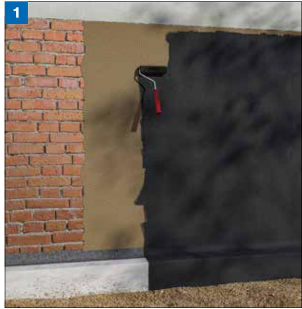
Bei Umgebungs- und Untergrundtemperaturen bis zu -5 °C ist DELTA®-THENE KÄLTEGRUNDANSTRICH einzusetzen. Die Verklebung sollte umgehend erfolgen. Für eine reibungslose und sichere Verlegung empfiehlt sich die temperierte Lagerung der Bahnen. Zusätzlich kann die Verklebbarkeit durch Anwärmen der Bahn mit einem Heißluftföhn verbessert werden.
