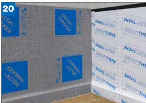
(Bild 20) Unmittelbar nach den Abdichtungsarbeiten sollte zum Schutz der Abdichtung vor mechanischen Beschädigungen während der Anfüllung DELTA®-TERRAXX montiert werden. Die Bahn sorgt für zuverlässigen Schutz und eine sichere Flächendränung.
