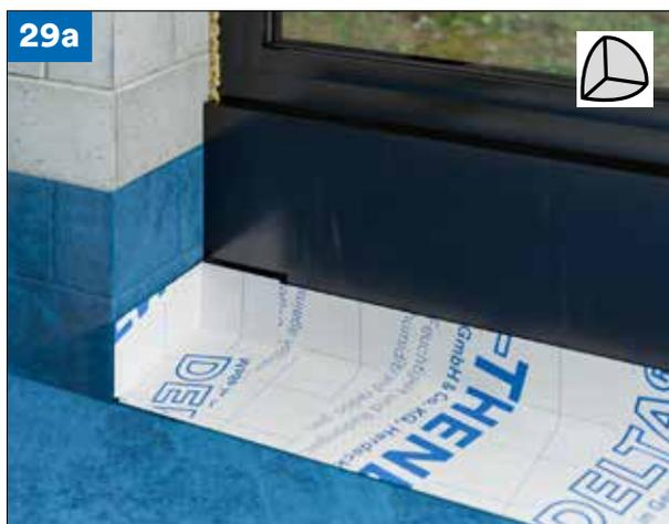
**(Bild 29a)**. Für den seitlichen Anschluss zur Leibung hin einen ausreichend großen Zuschnitt erstellen. Diesen hälftig aufkanten und auf der Seite des Aufstockelements im Knick ca. 10 cm weit einschneiden. In die Ecke setzen und auf dem vorhandenen Streifen DELTA®-THENE sowie an der Leibung sorgfältig ankleben (Tipp: Am besten einen Raketel verwenden) Streifen so angebracht, dass die zuvor eingefügten Fertigecken mind. 10cm überlappt
