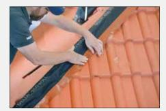
DELTA®-First- und Gratrollen möglichst gleichmäßig anformen. Zugspannungen die auf die Verklebung einwirken, müssen vermieden werden. Eine "Überstreckung" in Querrichtung der Rolle sollte vermieden werden.
