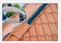
First und Gratziegel/-steine nach Herstellervorgaben befestigen. Die Firstziegel/-steine bzw. Gratziegel/-steine müssen das luftdurchlässige Mittelteil abdecken und die Flächenziegel/-steine ausreichend überdecken
