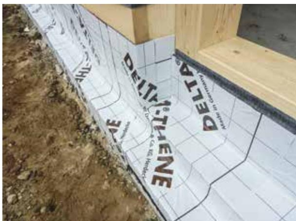
Speziell zugeschnittene Streifen von DELTA®-THENE für die Verlegung, z. B. an Kanten, Ecken, Hohlkehlen und Rohrdurchführungen. Mit geteiltem rückseitigem Trennpapier für eine einfache Verarbeitung.
