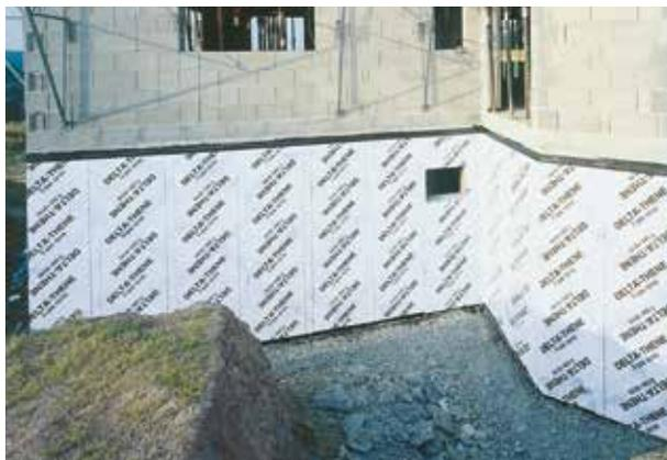
DELTA®-THENE ist eine hervorragende Dampfsperre.
