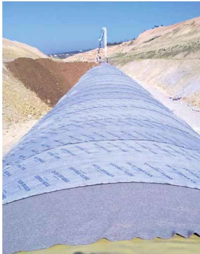
DELTA®-TERRAXX ist ein sicherer Schutz gegen Druckwasserbelastung.
