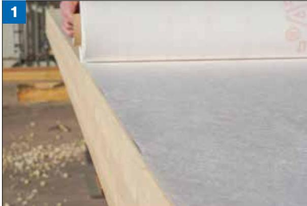
Préparer le support en retirant les éclats et les vis qui dépassent, puis le nettoyer avec un balai ou de l'air comprimé. Une attention particulière sera portée au niveau des joints de panneaux, des fraisages, perçages, ou zones où la membrane repose dans le vide afin d'éviter qu'elle ne soit endommagée ou perforée par des copeaux ou échardes.
