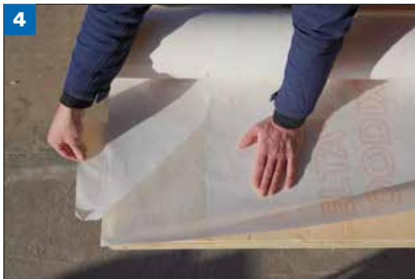
**(Figure 4)** Faire adhérer par pression la membrane sur une surface d'environ 10 × 10 cm, la dérouler sur quelques mètres et l'aligner sur la ligne pointillée de recouvrement. Retirer latéralement le film de protection FP 1 dans le sens de la membrane et poursuivre son déroulement en corrigeant régulièrement son alignement et en exerçant une légère traction. N'exercer dans un premier temps que de faibles pressions sur la membrane pour d'éventuelles corrections.
