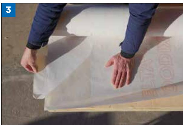
**(Figure 3)** Mettre le rouleau en place, retirer le film pelable le plus étroit (FP 1) sur une longueur d'environ 50 cm, le plier sous la membrane de manière à former un triangle et à positionner le film de protection (FP 1) perpendiculairement à la membrane.
