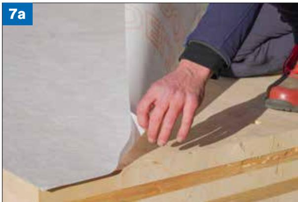
**(Figures 7a et 7b)** Retirer le film de protection FP 2 sur le même principe que décrit ci-dessus. Veiller à ce que le film perlable FP 2 soit légèrement tendu dans le sens de déroulement de la membrane afin d'éviter tout risque de déchirure.
