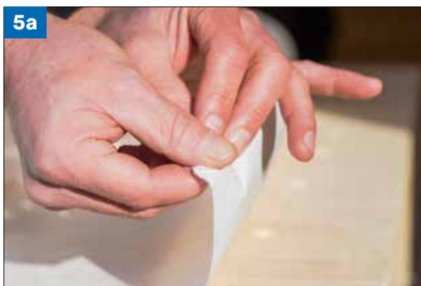
**(Figures 5a et 5b) Astuce pour décoller le film pelable :** Plier un petit coin de la bande, le serrer entre les doigts un court instant puis relâcher la pression. Le film de protection se détache ensuite très facilement.
