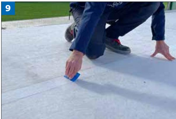
**(Figure 9)** La finalisation du collage du recouvrement à l'aide d'une marouflette est recommandée. Celle-ci permettra d'assurer un collage uniforme etc sans cloques.
