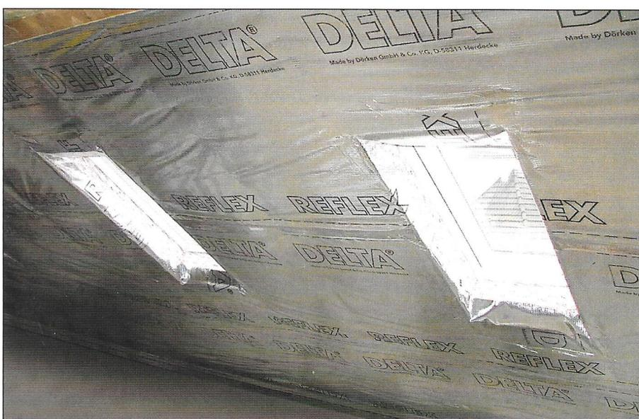
**Die UV-Strahlung gelangt jedoch auch von innen an die Unterdeckbahn oder – wenn das Dach bereits für den Innenausbau vorbereitet wurde – an die Luft- und Dampfsperre. Bei offen liegenden Bahnen sollten Dachflächenfenster deshalb vorsorglich verdunkelt werden, um das Material zu schützen.**
