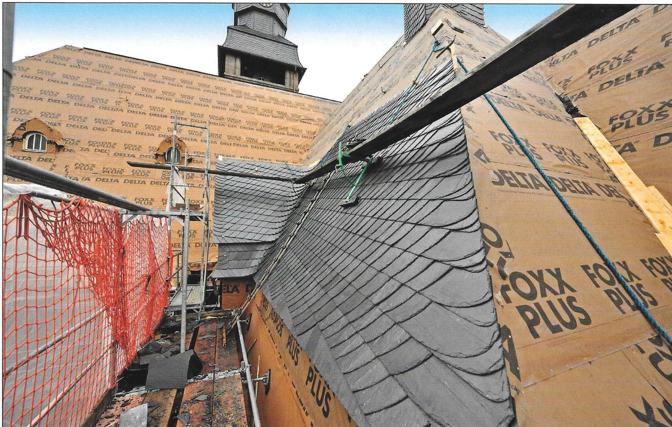
Fachleute am Dach wissen, dass Unter- und Vordeckbahnen nicht unnötig lange der UV-Strahlung ausgesetzt sein sollten. Hochwertige Bahnen sind zwar durch den Zusatz von Stabilisatoren gegen UV-Strahlung geschützt. Doch dies sollte nur als Sicherheitsreserve gesehen werden, zum Beispiel wenn die Eindeckung längere Zeit in Anspruch nimmt.
