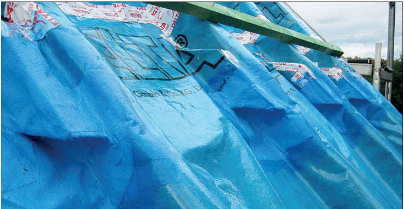
Für die luftdichte Einbindung komplexer Details, wie sie zum Beispiel bei dieser Dachsanierung von außen im Bereich der Kehlbalken entstehen können, hat sich laut Hersteller Dörken die pastöse Funktionsbeschichtung „Delta-Liquixx“ bewährt. Das Foto zeigt die Baustelle vor Montage der Presslatten an der Unterkante der Sparren.
