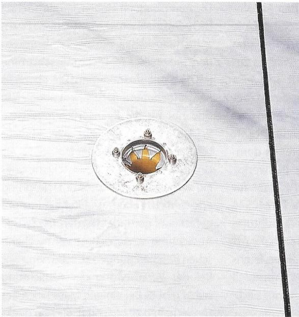
Abläufe zur Entwässerung von Belagsoberflächen, die die Abdichtung durchdringen, müssen sowohl die Belagebene als auch die Abdichtungsebene dauerhaft entwässern. Abläufe müssen in der Weise geplant und eingebaut werden, dass sie für Wartungszwecke zugänglich sind.
