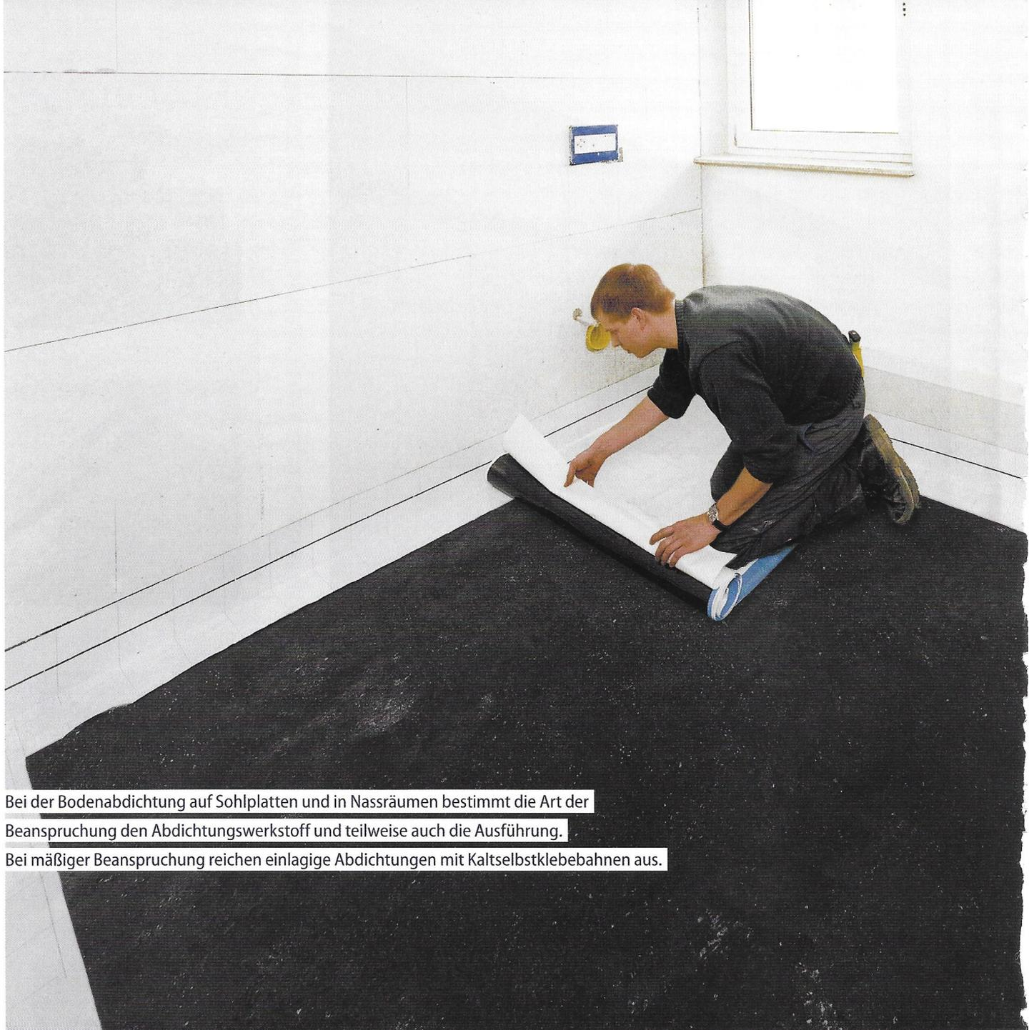
Bei der Bodenabdichtung auf Sohlplatten und in Nassräumen bestimmt die Art der Beanspruchung den Abdichtungswerkstoff und teilweise auch die Ausführung.
