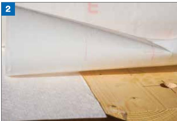
**(Bild 2)** Alle folgenden Bahnen unter Beachtung der gestrichelten Überlappungslinie (12 cm) ausrichten. Sollte die Bahn leicht verlaufen, darf die Mindestüberdeckung von 10 cm nicht unterschritten werden. Die Richtung des Wasserlaufs sollte beachtet werden.
