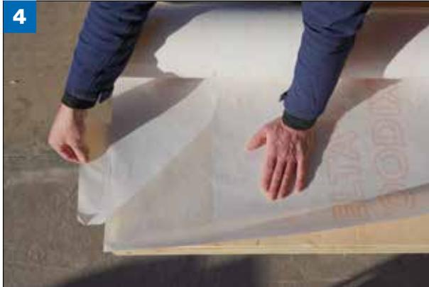
**(Bild 4)** Eine handgrosse Fläche fixieren, die Bahn einige Meter ausrollen und an der Überdeckungslinie ausrichten. T1 unter gespannter Bahnenrolle seitlich hervorziehen und rechtwinklig zur Rollenrichtung mit der Zughand auf Bahnniveau fortlaufend herausziehen, dabei die Bahn unter leichtem Zug abrollen und ausrichten. Die Bahn für mögliche Korrekturen vorerst leicht anheften.
