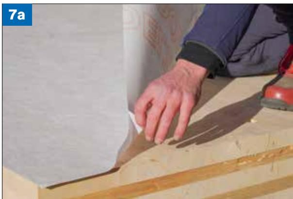
**(Bild 7a und Bild 7b)** Die verbliebene T2 genauso herausziehen wie bei T1 beschrieben. Hierbei ist darauf zu achten, dass T2 auf Bahnniveau leicht in Abrollrichtung abgezogen wird, um ein mögliches Einreißen der T2 zu vermeiden.
