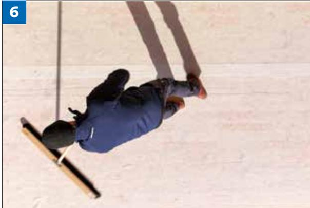
**(Bild 6)** Mit dem breiten Besen die Bahn im Bereich von T1 andrücken und dabei mögliche Lufteinschlüsse zur Bahnkante herausschieben.
