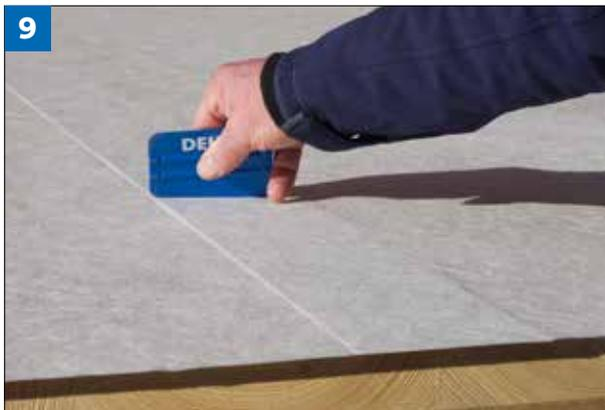
**(Bild 9)** Wir empfehlen die Überdeckungen mit dem DELTA®-RAKEL anzudrücken, um eine gleichmässige und blasenfreie Verklebung sicherzustellen.
