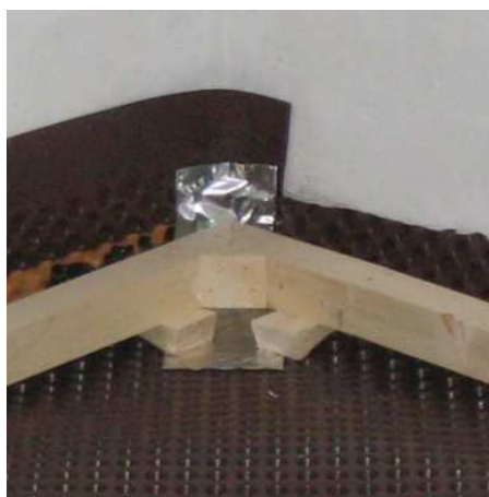
Az oldalfalra felhajtott dombornyomott lemez a kiékelte párnafákkal
