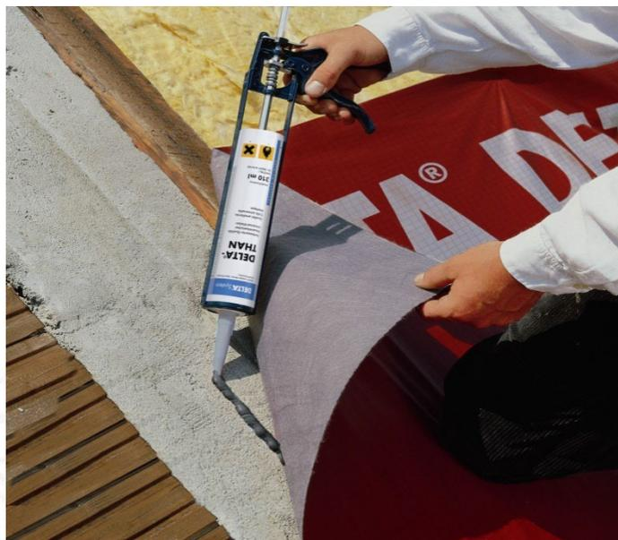
**Description:** colle pour les raccords aux murs. Pour le collage des recouvrements des feuilles DELTA® (sauf pour la gamme DELTA®-MAXX).
