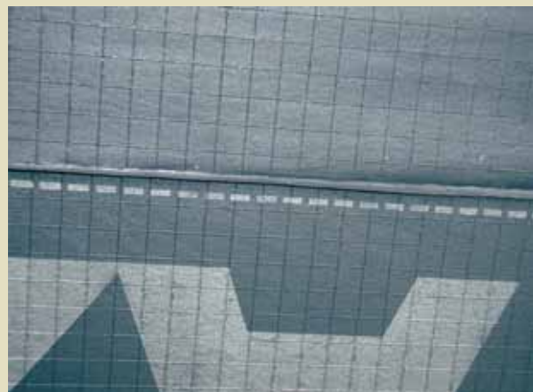
↑ Auch der Schnurschlag für die Ausrichtung der Anschlussbahn konnte entfallen. Die Rasterlinien dienen auch hier als genaue Orientierungshilfe für eine fluchtgerechte Verlegung.
