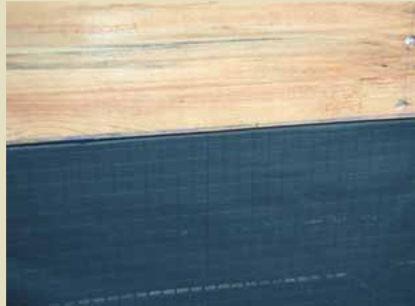
↑ Dann wurde die Fassadenbahn entlang des Schnurschlages ausgerichtet. Die Bahn wurde dabei straff gespannt und ausreichend fixiert, damit das Material nicht durchhängt oder im Wind flattert.
