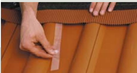
2. Trennstreifen abziehen.
