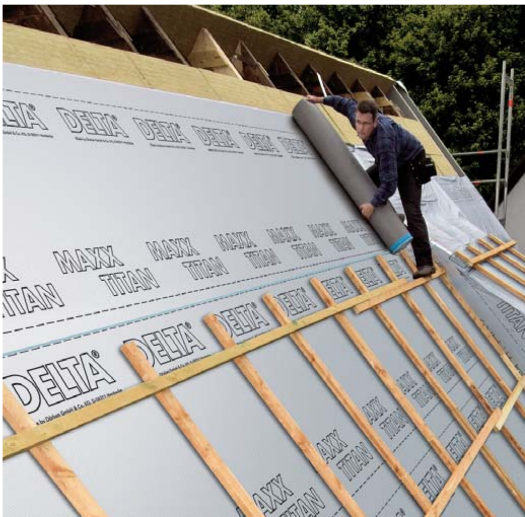
DELTA®-MAXX TITAN besitzt eine ganzjährige Wärmeschutzfunktion und senkt die Luftwechselrate.
